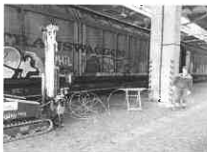
CMT kút kiépítése a csarnokon belül
